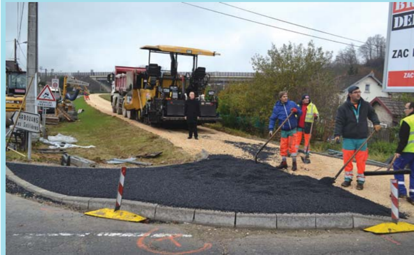
Début décembre, l'entreprise posait la couche d'enrobé.
