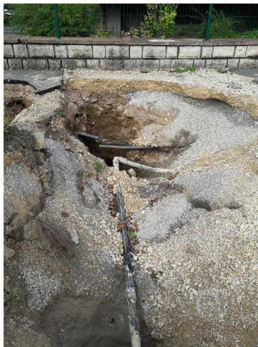
Fontis avec encombrement du sous sol et éboulement
