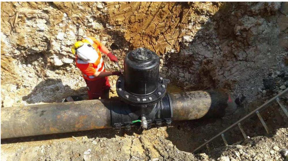
Vanne en charge diamètre 400 mm chantier hexagones de Montbéliard
